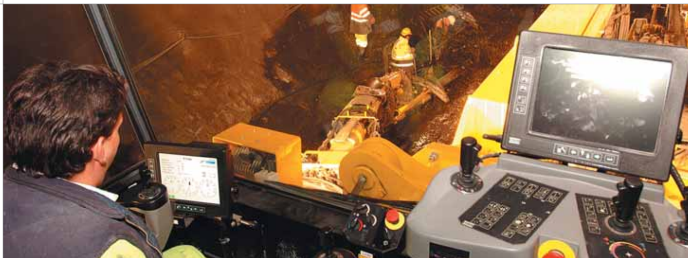
Saint-Martin La Porte, cabine foreuse
