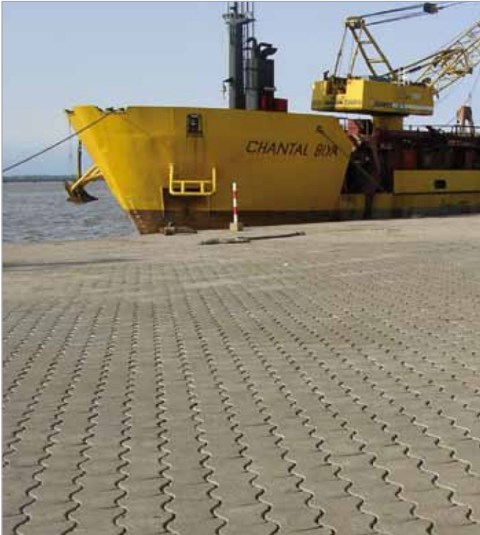
Maître d'ouvrage : Port autonome de Douala Mission de contrôle : Seamar Engineering/Cadek
