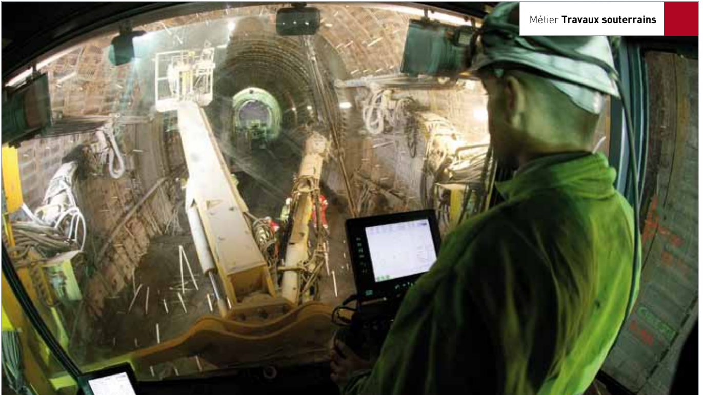
Maître d'ouvrage : Lyon Turin Ferroviaire Maîtres d'œuvre : Egis Tunnels (ex Scetauroute) – Antéa – Alpina
